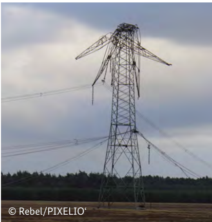
Sturmschaden durch den Orkan Kyrill im Jahr 2007
