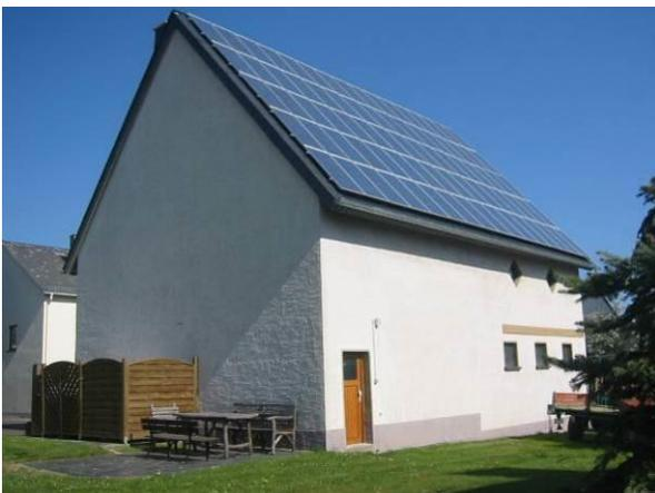
Wo es, wie auf dem abgebildeten Nebengebäude nicht möglich ist, die Anlagen vollflächig anzuordnen und damit die Wirkung der Dachfläche als Einheit zu erhalten, sollten die Anlagen in Gruppen zusammengefasst, an First oder Traufe bzw. am vorgegebenen Fassadenraster orientiert werden. Bei Neubauten sollten die Anlagen gleich in die Planung einbezogen werden und z.B. mit Dachfenstern zu einem durchgehenden Band kombiniert werden.
