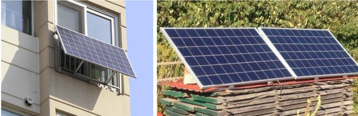
Abbildung 7-8: Beispielhafte Installation von Plug and Play PV-Anlagen ( (eprimo, k.A.) und (Mein-Eigenheim, 2018)
