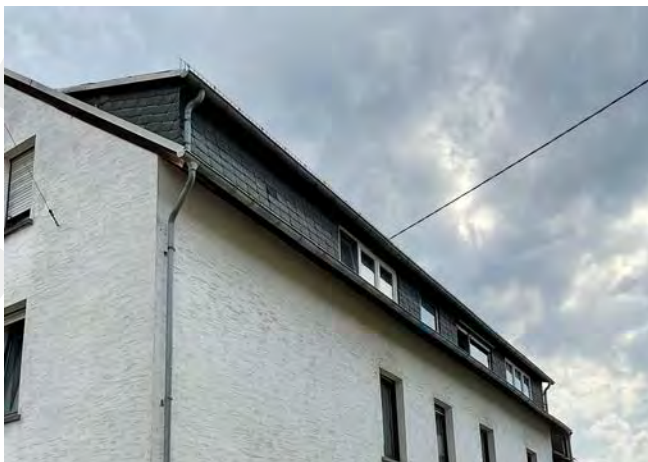
Dachgauben, Siedlung Dornberg (Walter-Liebig-Straße)
