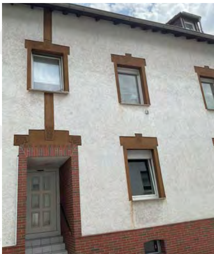
Historische Fenstergewände, Walter-Liebig-Straße
