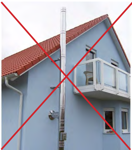
Außenschornsteine an der Straßenfassade
