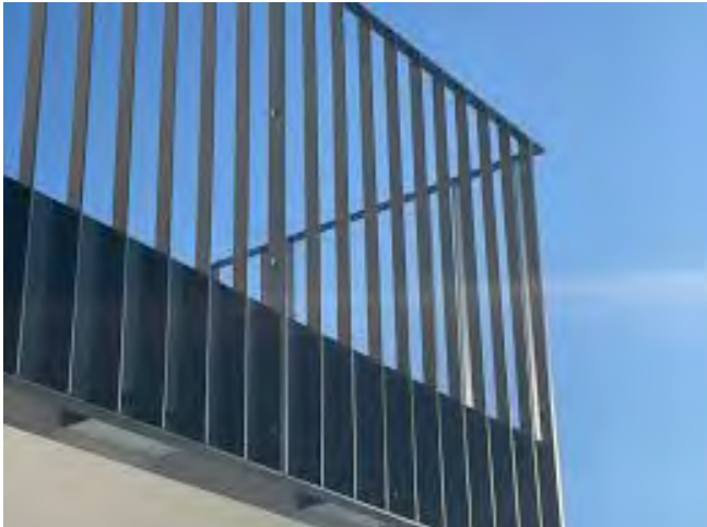
schlichtes Geländer an einer Dachterrasse im rückwärtigen Gebäudebereich
