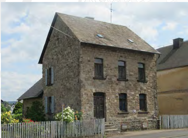
Holzlichtige Fenster und Holztüre, Christian-Heibel-Straße
