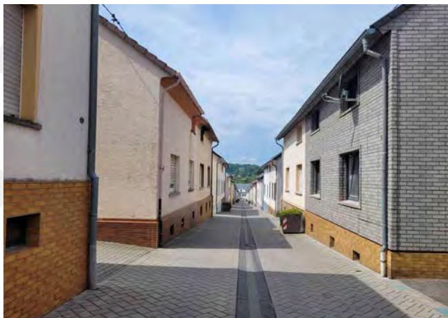
Klare Baufluchten und traufständige Stellung der Gebäude, Siedlung Dornberg
