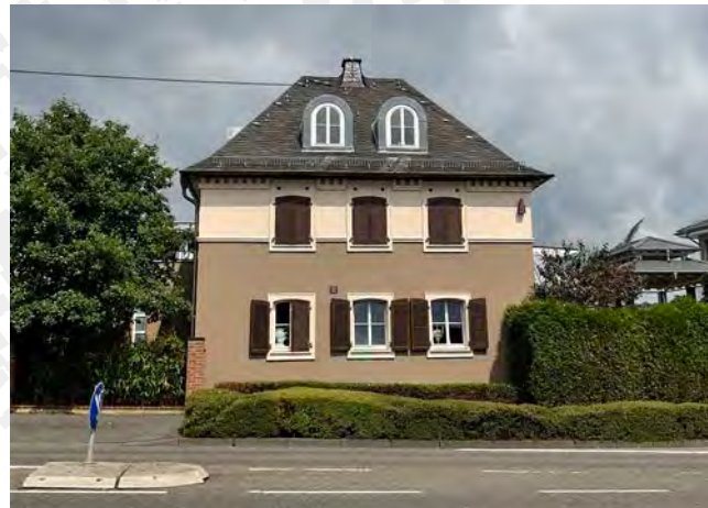
klare Gliederung durch Fassaden- und Farbgestaltung
