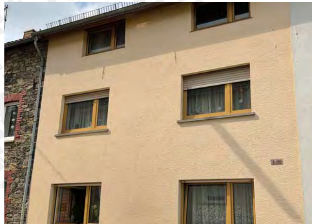
Natursteinfassade und helle Putzfassade, Leipziger Straße
