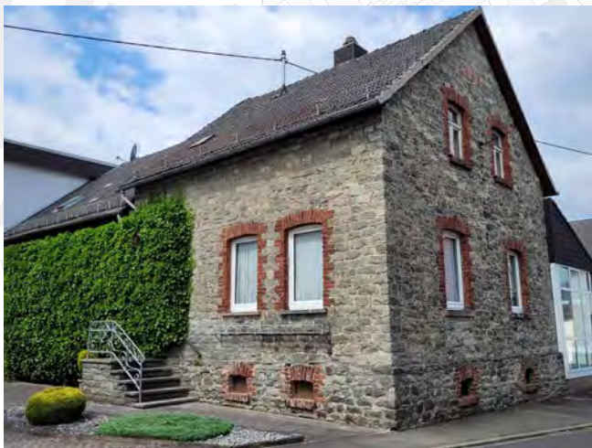
Natursteinfassade mit Sockelzone, Burgstraße
