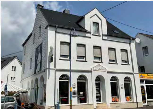
Klare Gliederung durch Fassadengestaltung
