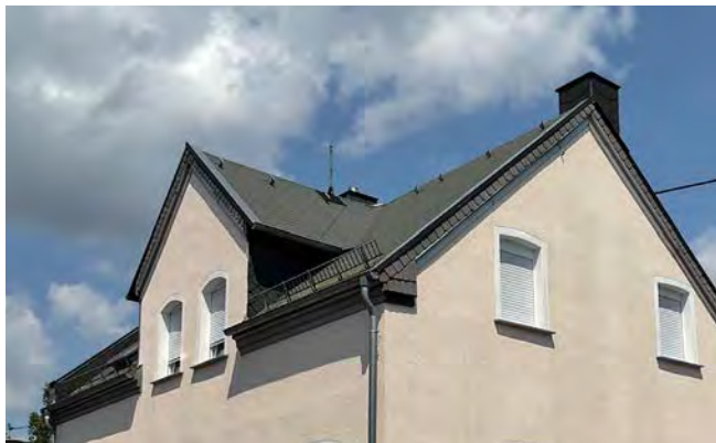
Anthrazite Dacheindeckung mit schmalem Ortgang und Ortgangziegeln
