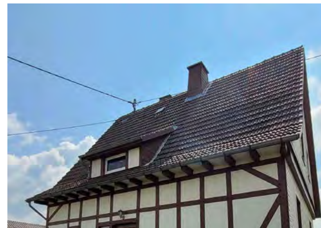
Satteldach mit Schleppgaube, Burgstraße
