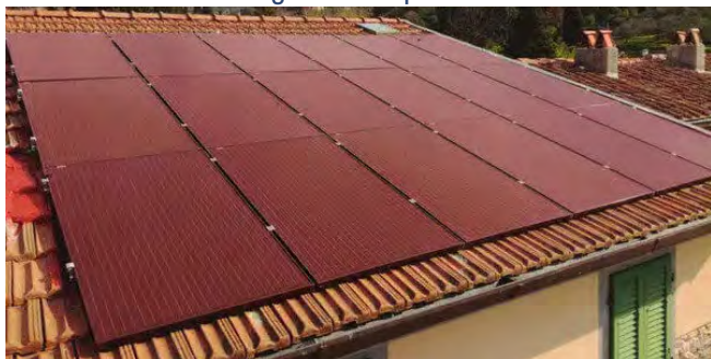
Solarpaneele in farblicher Angleichung an Dacheindeckung
