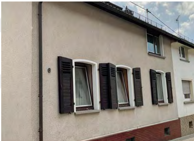
Holzlichtige Fenster und Klappläden, Walter-Liebig-Straße
