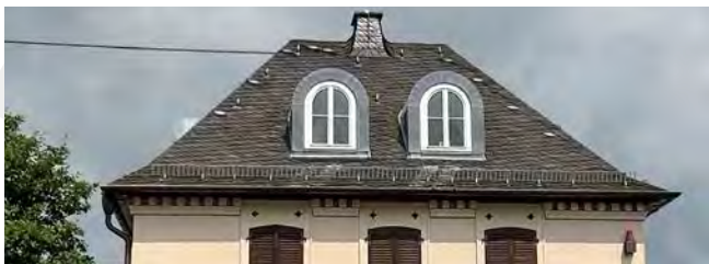
Walmdach in der Bahnstraße
