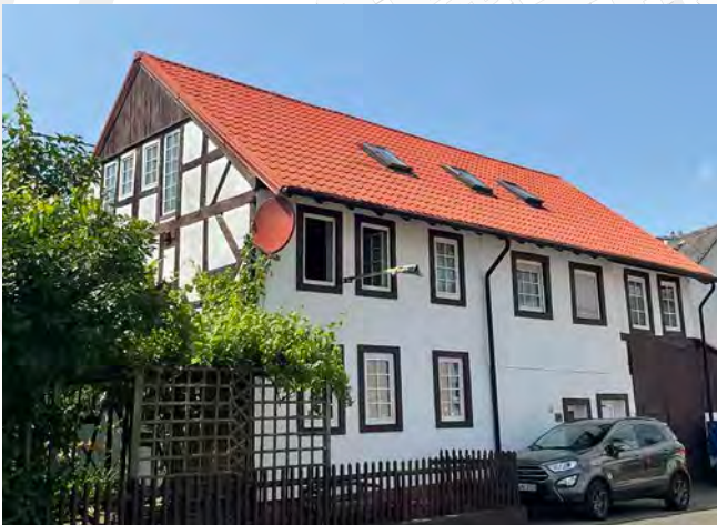
Fachwerkgebäude mit verputzten Gefachen
