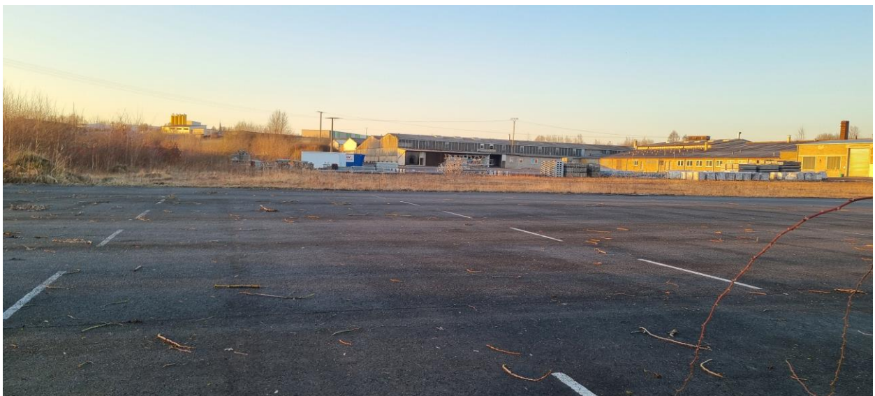
Foto 1: Lagerflächen mit Schwarzdecke im südlichen Randbereich des Plangebietes
