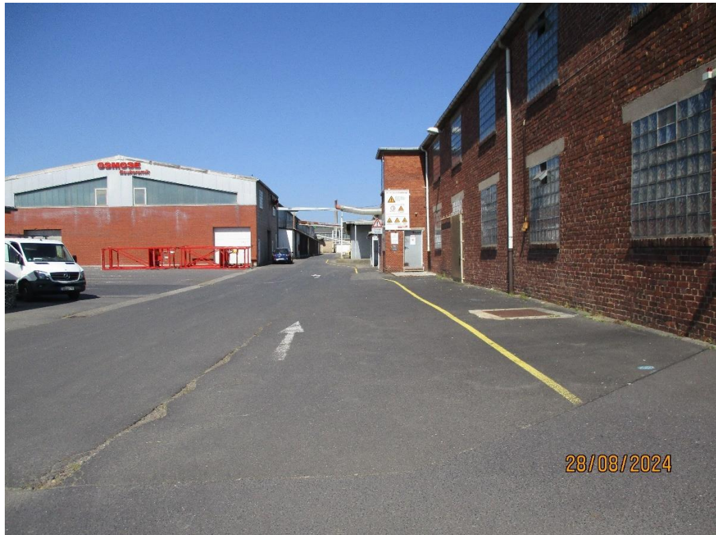
Abb. 8 Gebäude im Plangebiet der ehemaligen „OSMOSE KG“
